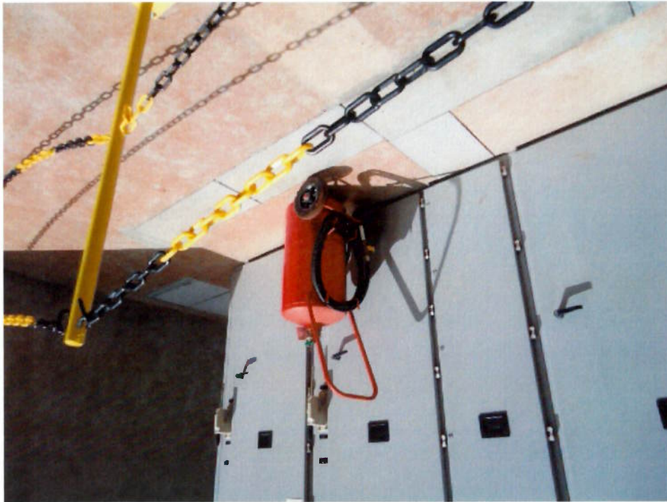
Figura 20– Vista das unidades extintoras manuais instaladas na PCH. Fonte: Arquivo Pessoal
