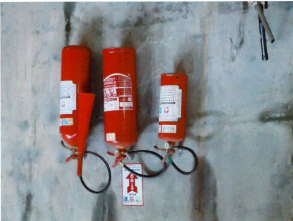
Figura 20– Vista das unidades extintoras manuais instaladas na PCH. Fonte: Arquivo Pessoal
