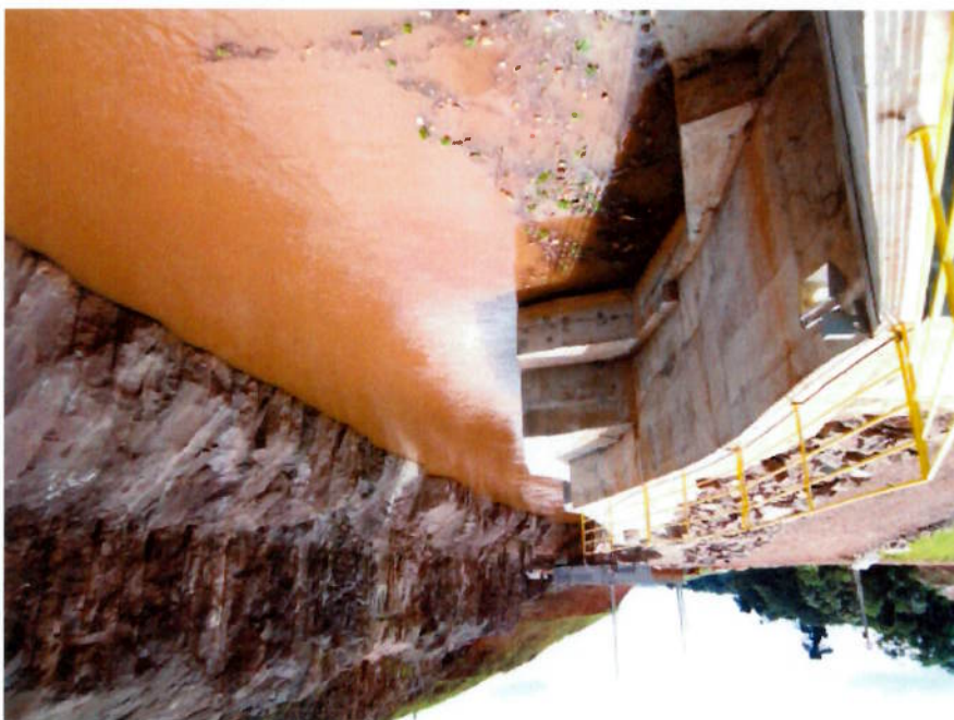
Figura 18– Vista do canal de adução de água escavado em rocha. Fonte: Arquivo pessoal
