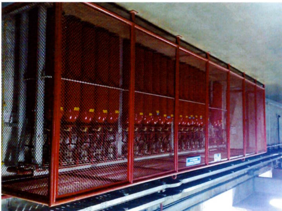
Figura 12– Vista de cilindros de gás carbônico. (Fonte: Arquivo pessoal)
